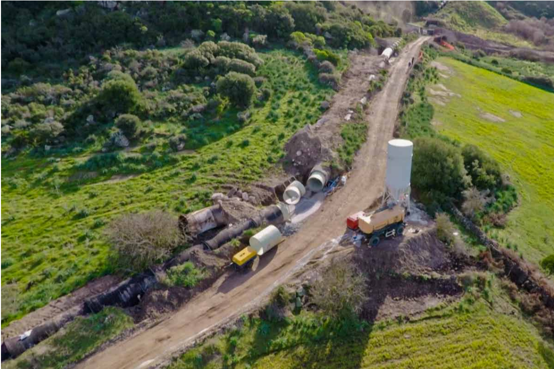
Aus Baugruben in Kurvenbereichen werden die GFK-Rohre in die unterirdischen Abschnitte der Druckrohrleitung eingezogen. Foto: ROTECH
