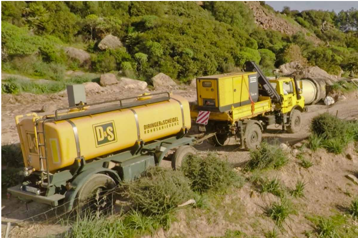
Transport des Wassers für die Injektionsarbeiten.
