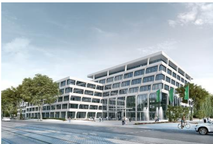
Blick von der Berliner Straße auf die neue Hauptverwaltung von HeidelbergCement.
