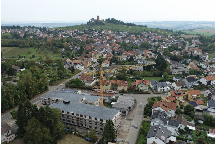
Aufnahme Ende September 2021: Der Rohbau der neuen Pflegeeinrichtung steht und die Bauarbeiten liegen im Zeitplan
