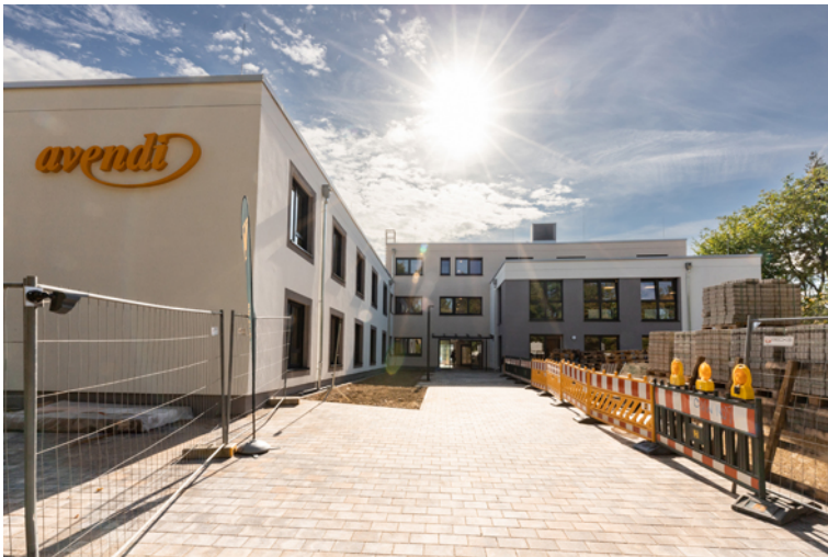
Bild 4: Die letzten Arbeiten an den Außenanlagen werden bis Ende September abgeschlossen sein.
