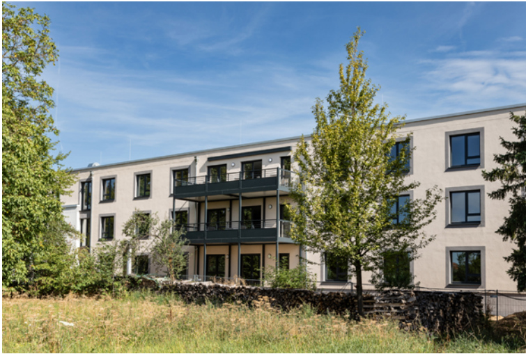
Bild 3: Jede Wohngruppe des neuen, von D&S geplanten und realisierten Pflegeheims verfügt über einen großzügigen Aufenthaltsbereich und Terrasse / Balkon, wie hier auf der Südseite zu sehen
